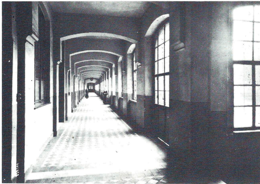
Un lieu immuable : Le couloir du rez-de-chaussée
